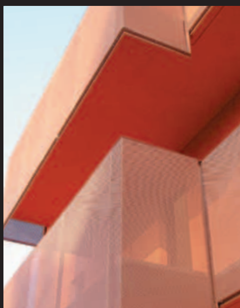
Malla: DL 16 x DC 8 - av 3 x sp 1,5mm - Acero al carbono sendzimir (pregalvanizado) lacado
