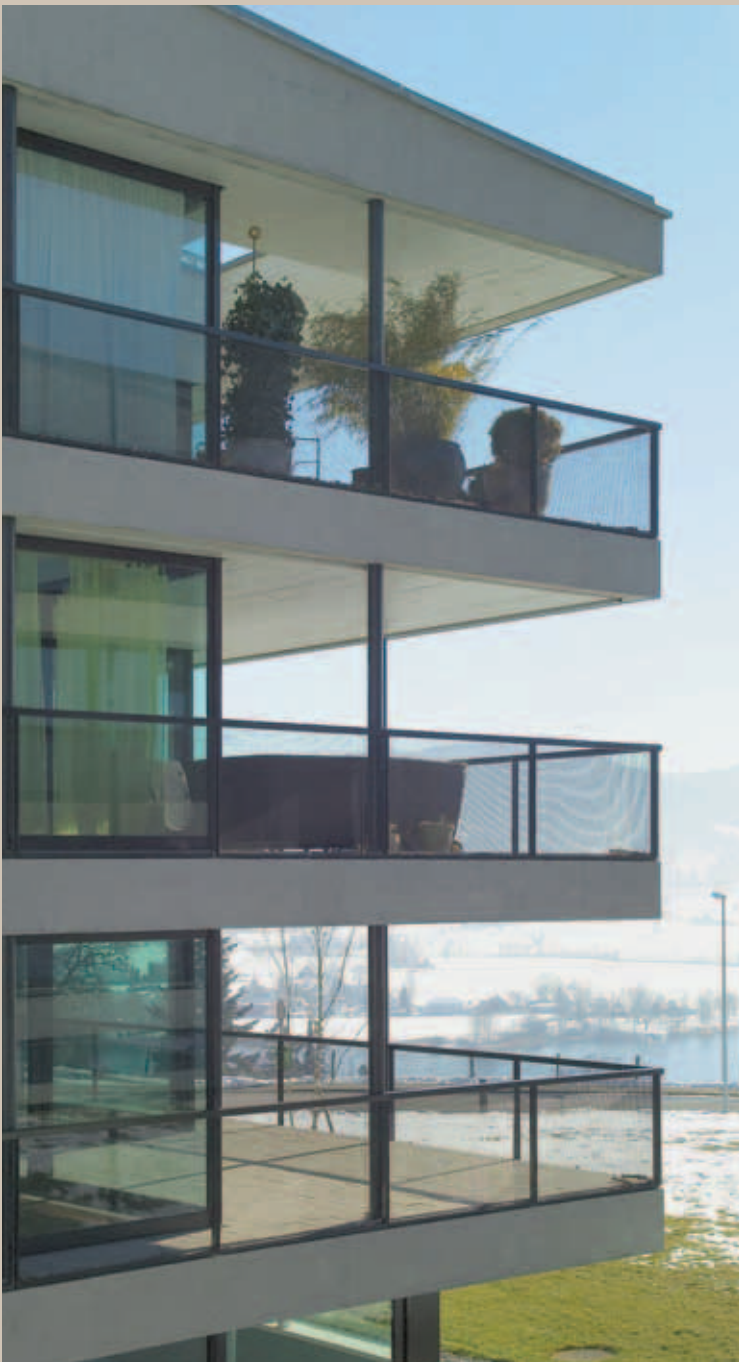
Proyecto: Dettli Nussbaumer Architekten GmbH (CH) - Malla: DL 28 x DC 14 - av 2 x sp 1,5 mm Acero al carbono galvanizado lacado - Foto: Huber
