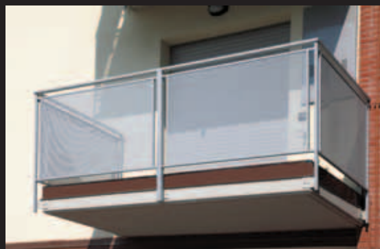
Parapetos realizados en chapa perforada con orificio redondo
