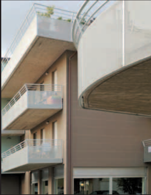
Malla: Chapa perforada - Orificio redondo
