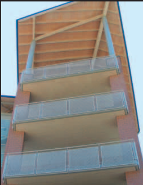
Malla: Esperia - Acero al carbono galvanizado en caliente
