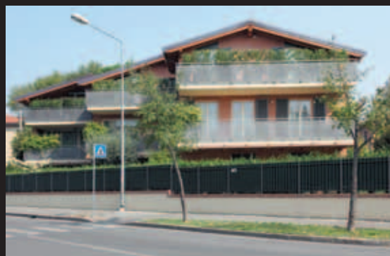
Parapetos realizados en chapa perforada con orificio cuadrado
