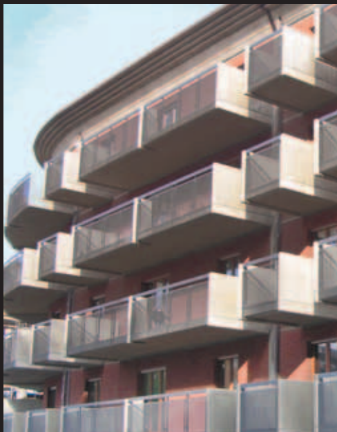
Malla: Fils 21 - Acero al carbono galvanizado en caliente
